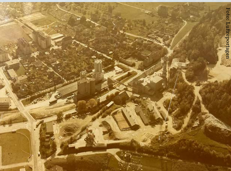
Kalkwerk 1981 in Richtung Leitendorf
